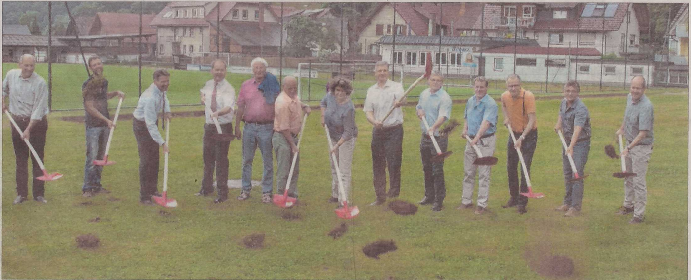
Gemeinsamer Spatenstich am Standort des zukünftigen Heizhauses: Hansjörg Kindle (von links), Thomas Lehmann, Gerold Erb, Arnold Allgeier, Manfred Vetter, Hubert Schwarz, Anja Jilg, Siegfried Huber, Rudolf Nock, Bernd Zimmermann, Ulf-Henning Palmer, Theo Gartner und Klaus Gall.
